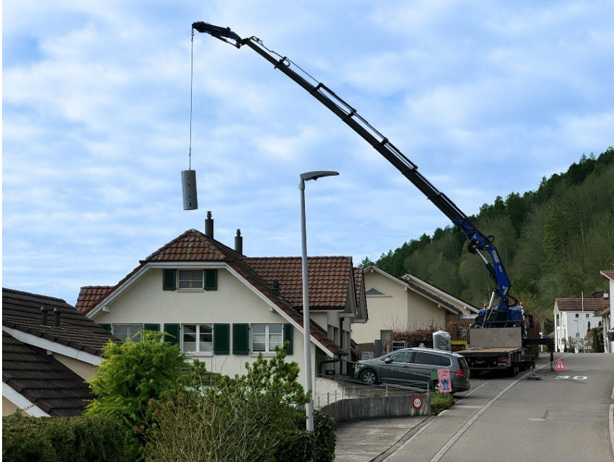
Livraison d'un accumulateur thermique pour une maison individuelle
