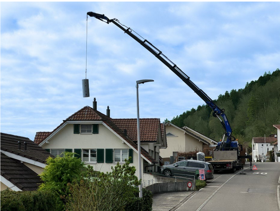
Anlieferung des Wärmespeichers für ein Einfamilienhaus
